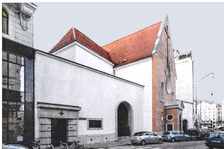
Klar erkennbar die rostrote, vorgebaute Fassadenscheibe der Kapuzinerkirche.
