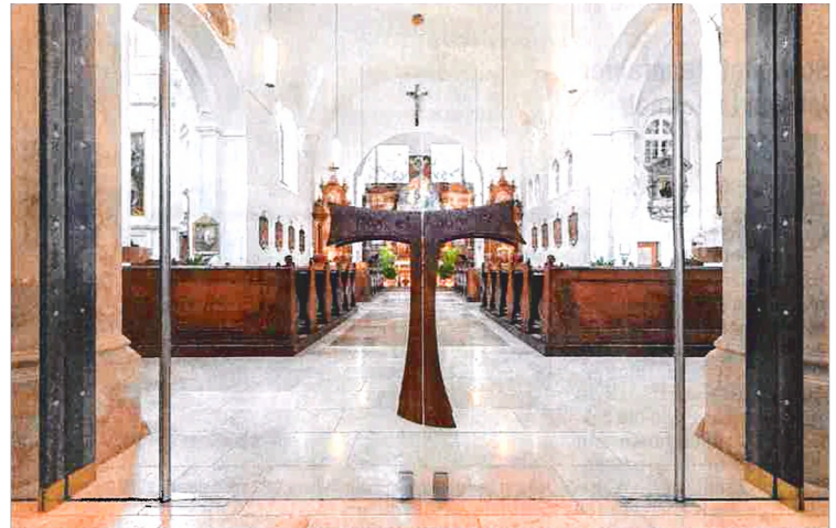
Der neue Windfang mit geöltem Stahl und viel Glas.
